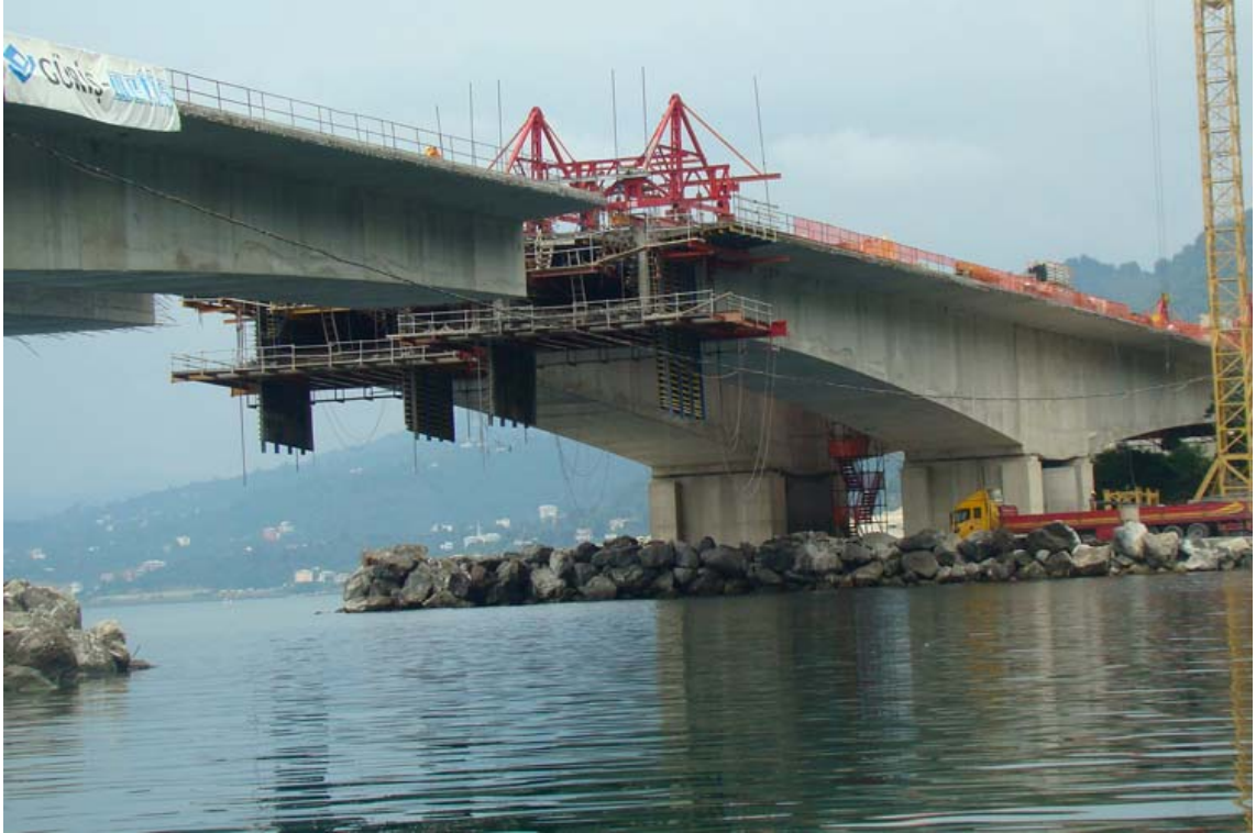
Şekil 1 Gülburnu Viyadüğü Uçan Kalıp uygulaması
